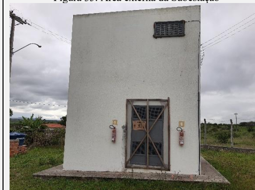
Figura 35. Área externa da Subestação
