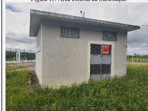
Figura 15. Área externa da Subestação
