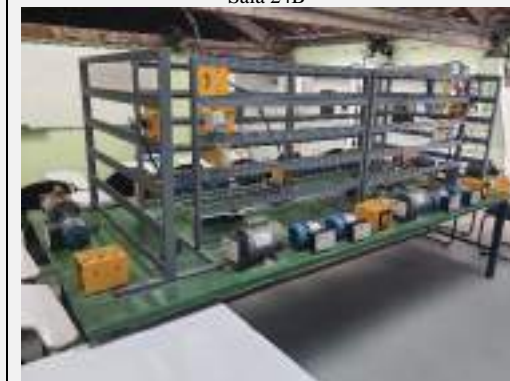
Figura 64. Área do Laboratório de Instalações Elétricas - Sala 24B
