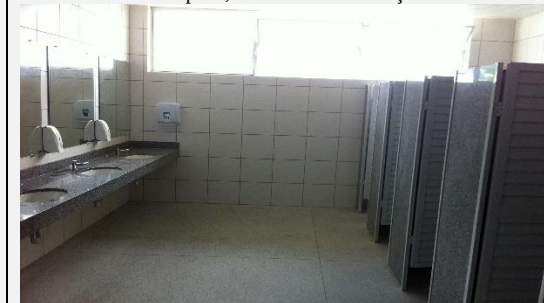
Figura 23. Área das Instalações Sanitárias – Serviços de Limpeza, Asseio e Conservação
