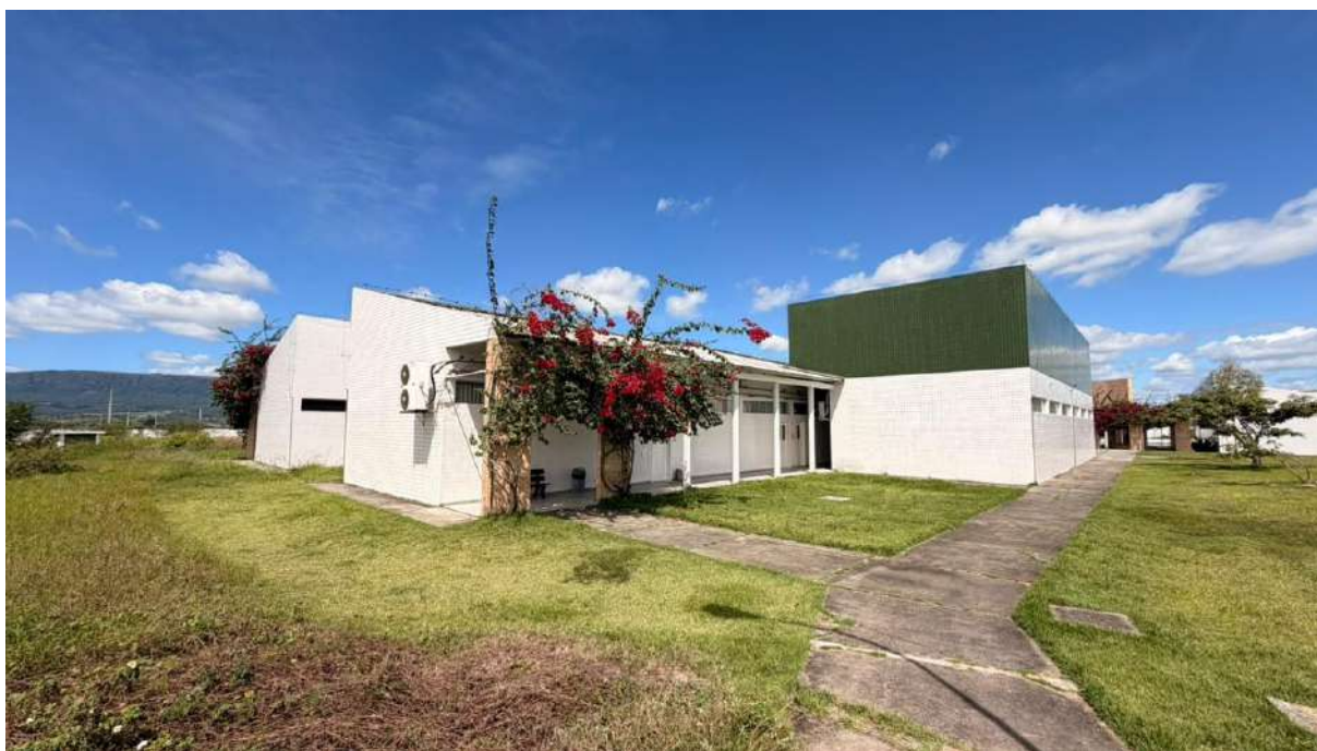
Fotografia 22 revestimento de fachada
