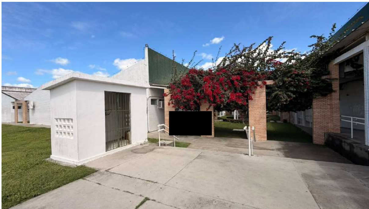
Fotografia 49 casa de bombas
