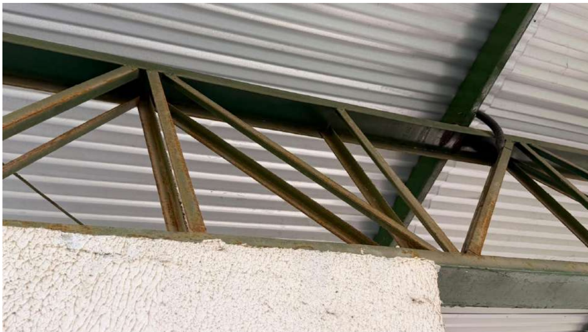
Fotografia 15 estrutura com ligação sem apoio
