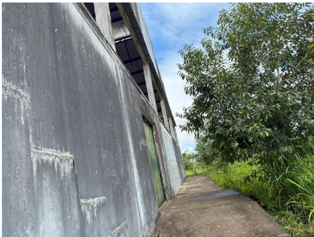
Fotografia 118 - Fachada de fundo ginásio
