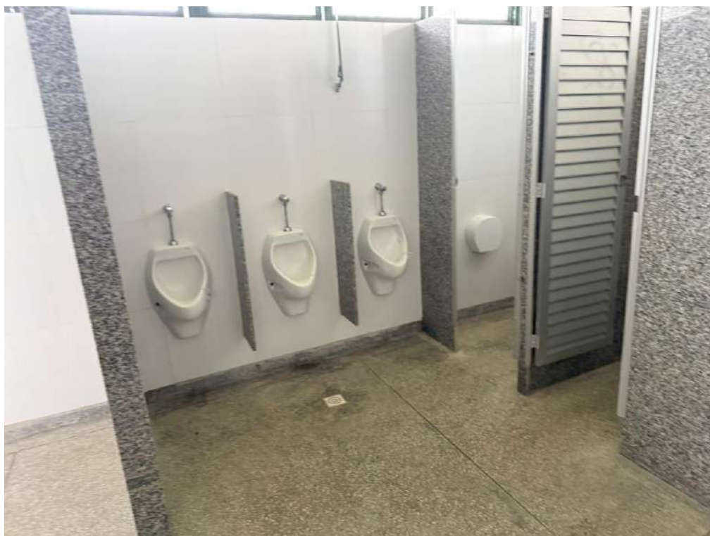
Fotografia 121 - Sanitários dos vestiários
