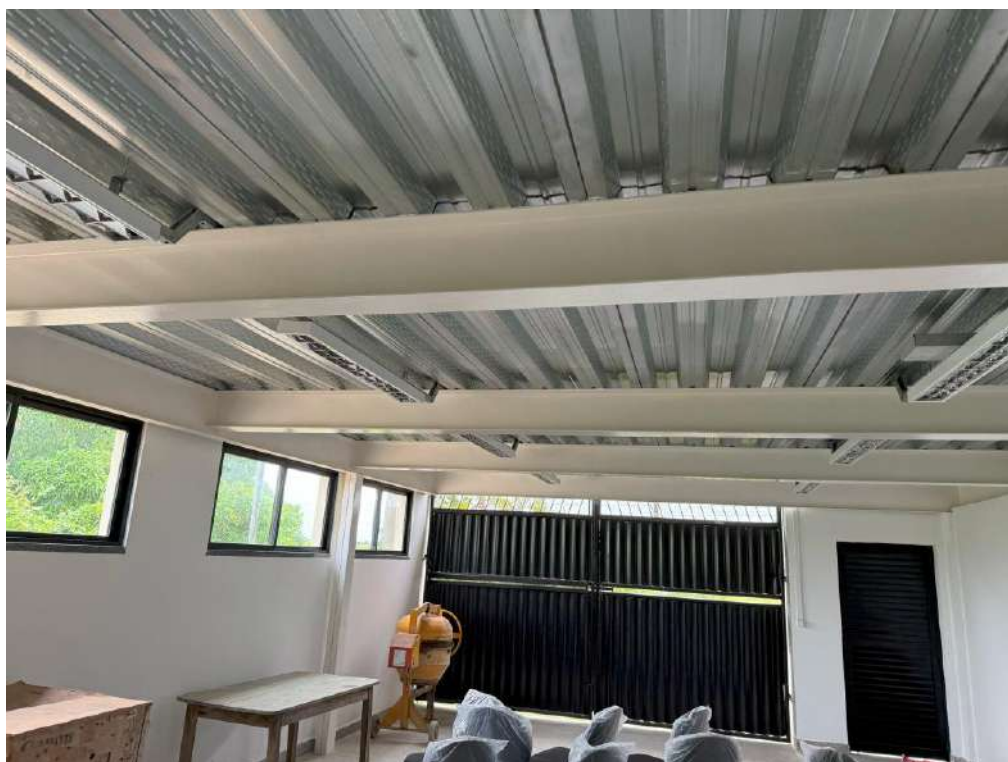
Fotografia 83 - Laje estrutura mista
