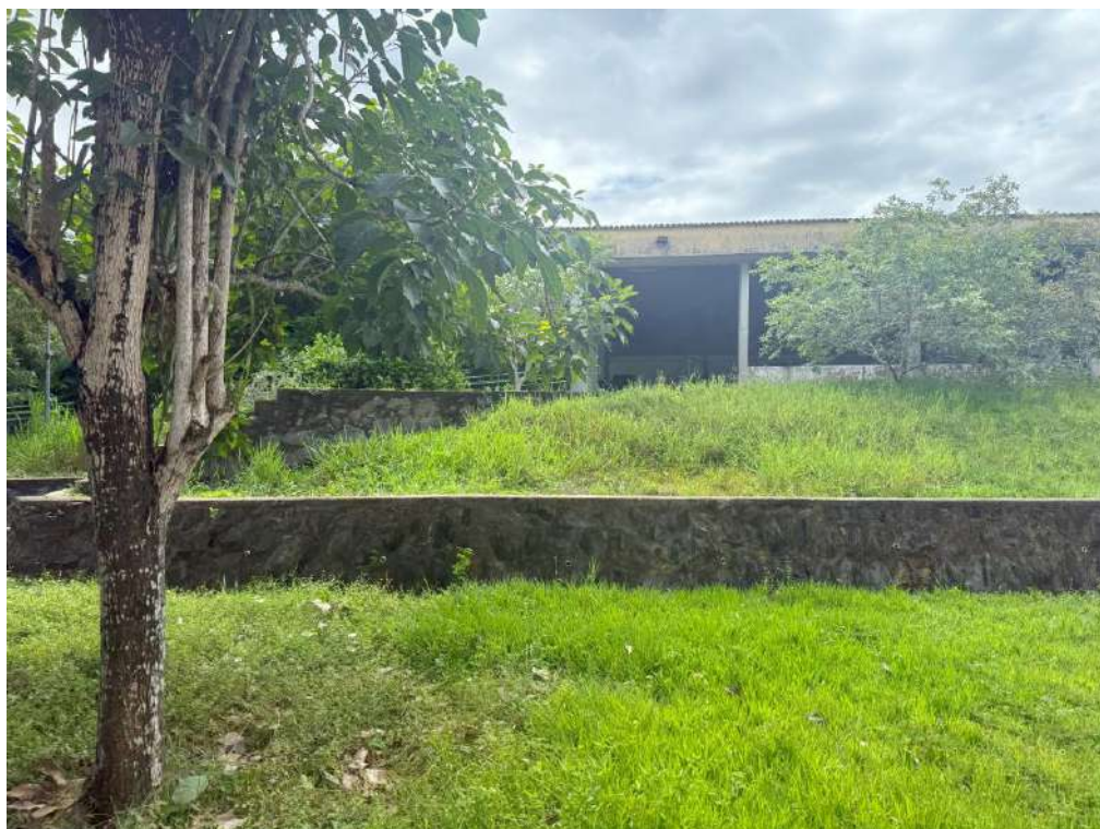
Fotografia 142 - Murro de arrimo
