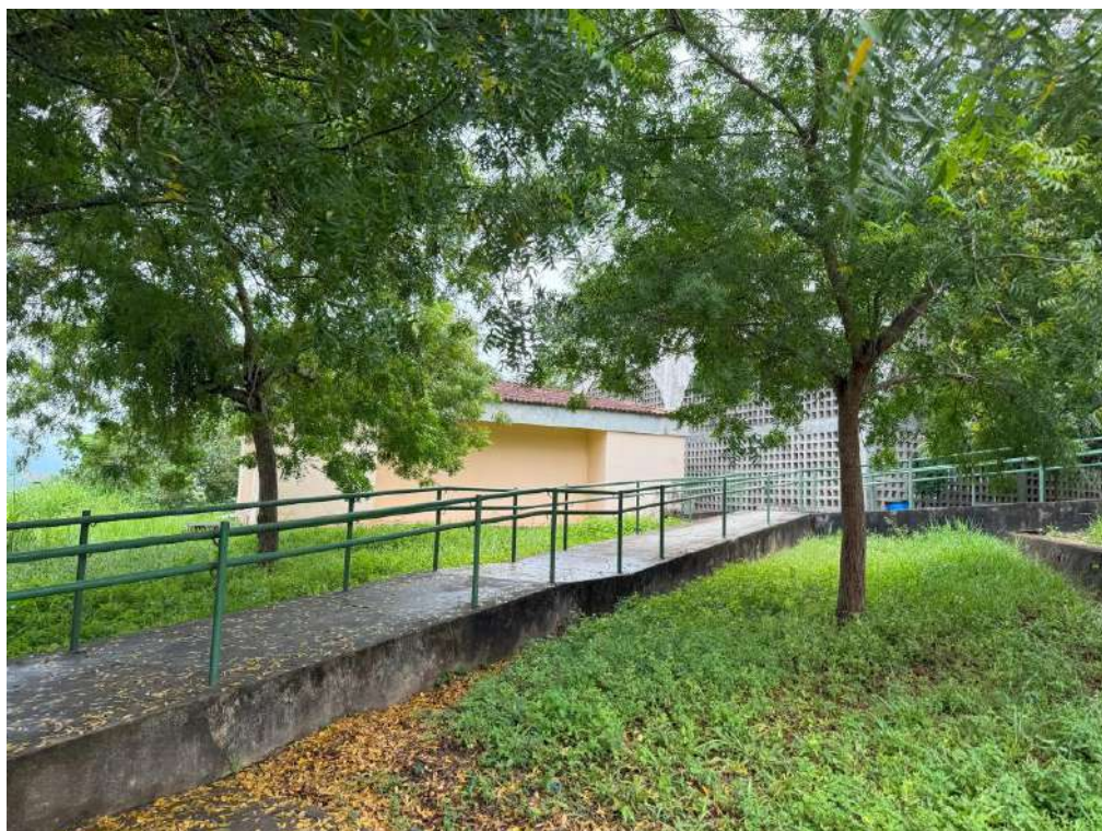
Fotografia 110 - Rampa de acesso Ginásio
