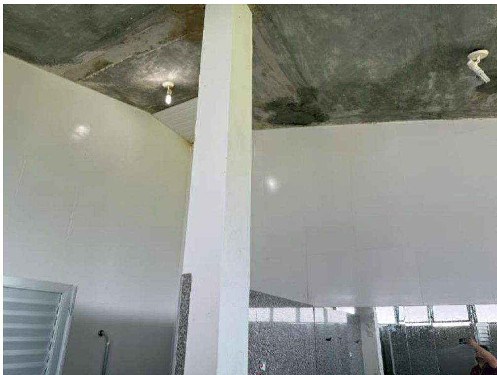
Fotografia 122 - teto dos vestiários
