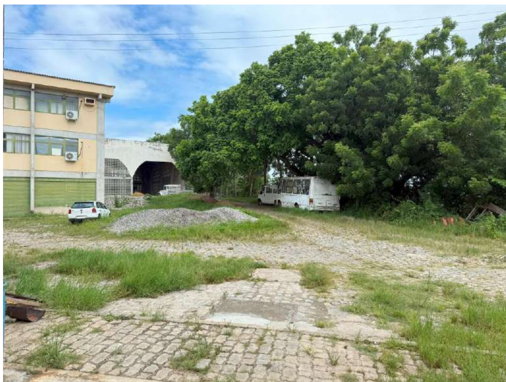
Fotografia 127 - Acesso a garagem
