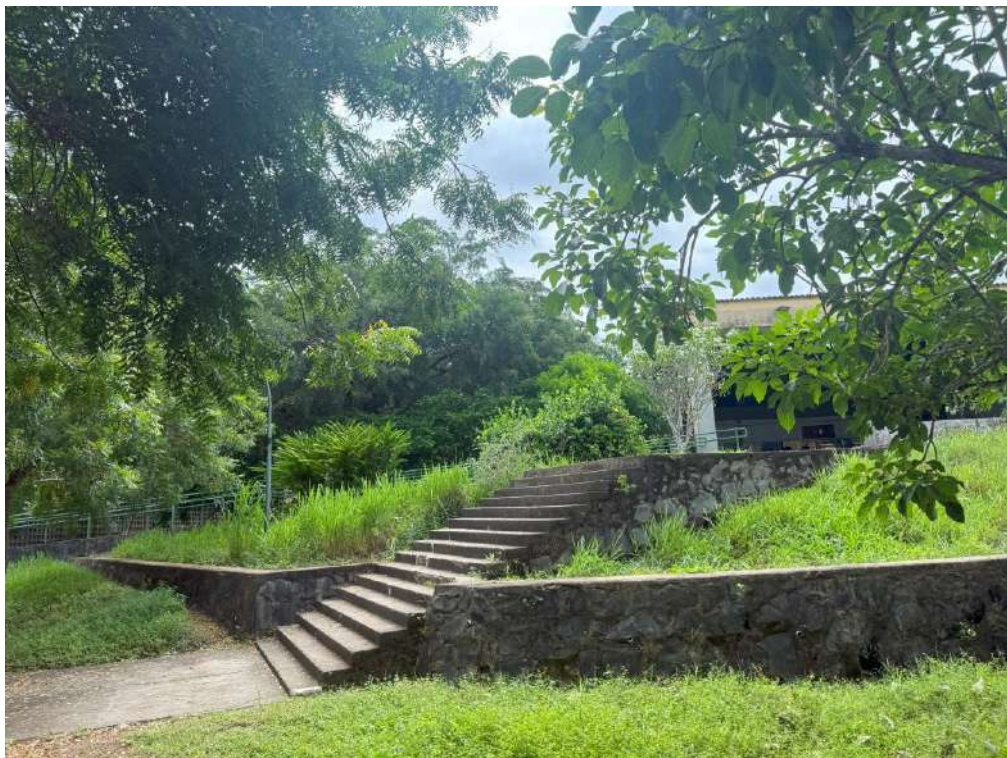
Fotografia 146 - Arrimo próximo a escadaria
