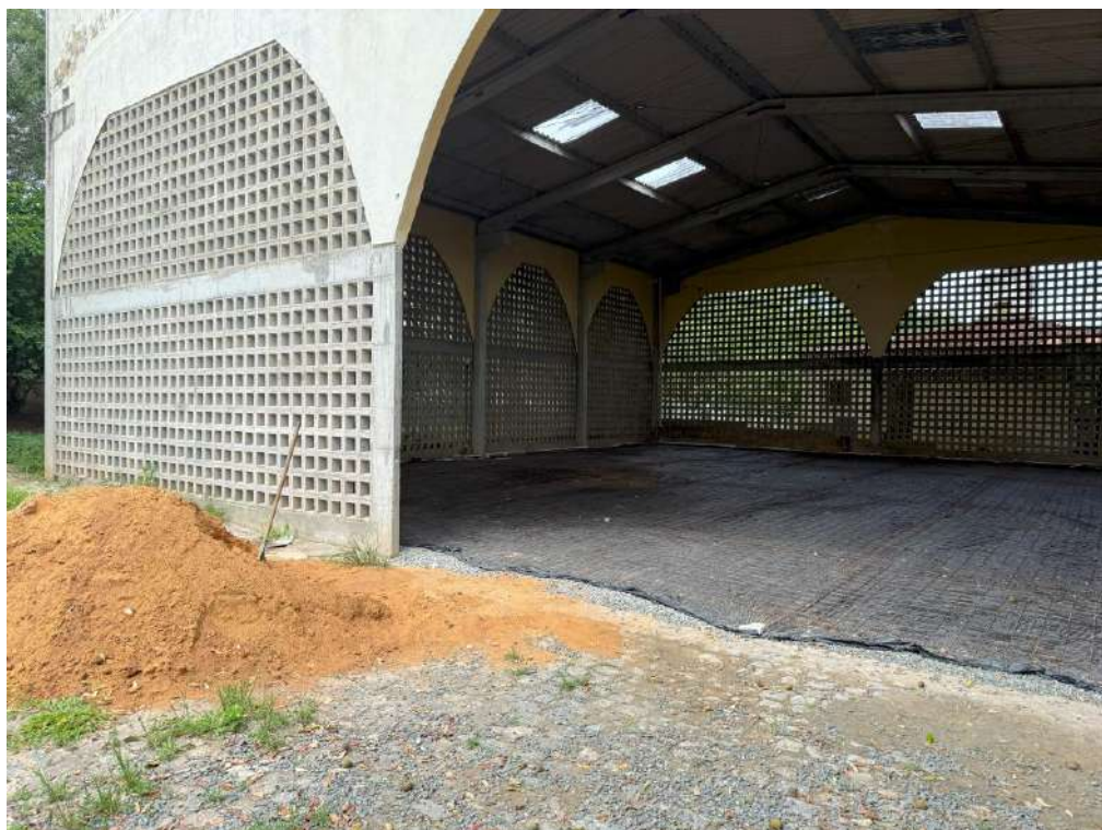
Fotografia 136 - Garagem em obras
