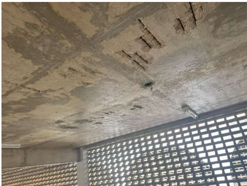
Fotografia 164 - Teto da Rampa
