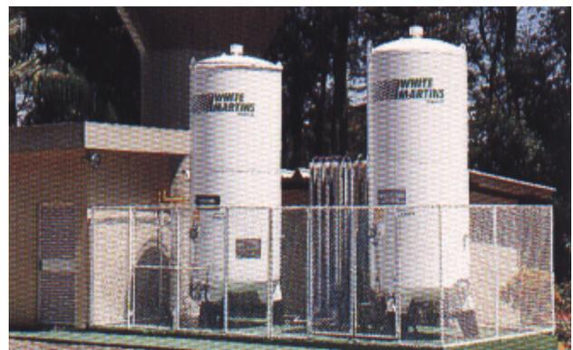
Fig 10. Tanque Criogênico
