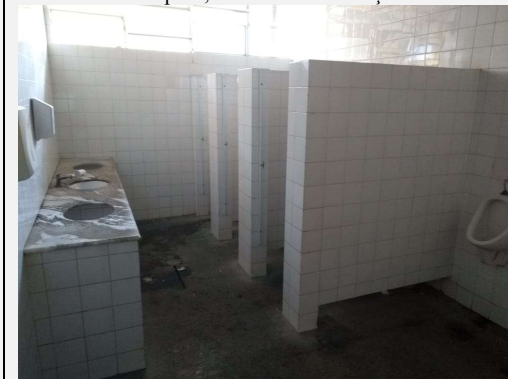
Figura 156. Área das Instalações Sanitárias - Serviços Limpeza, Asseio e Conservação
