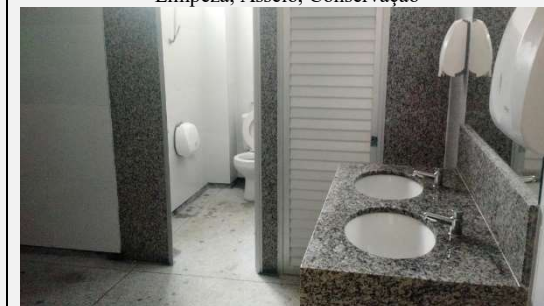
Figura 80. Área das Instalações Sanitárias - Serviços de Limpeza, Asseio, Conservação
