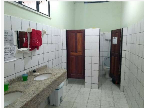
Figura 14. Área das Instalações Sanitárias – Serviços de Limpeza, Asseio e Conservação
