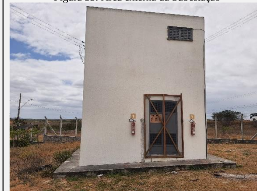
Figura 35. Área externa da Subestação
